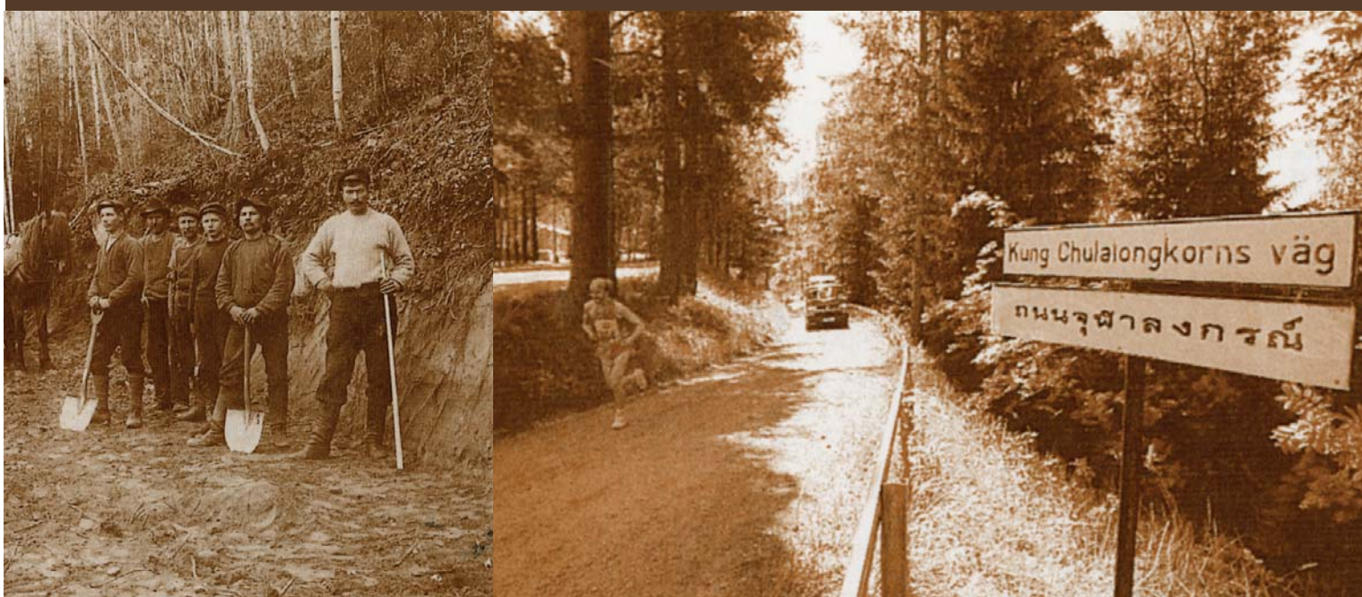
ปี พ.ศ. ๒๔๓๕-๒๔๓๗ มีการตัดถนนจากเอ็ดเซทถึงโฮล์มสตา ต่อมาถนนสายนี้ได้รับการตั้งชื่อว่า "ถนนจุฬาลงกรณ์มหาราช"
